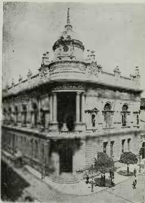
CAIXA DE CONVERSÃO
