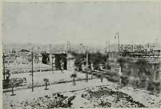
H. F. Central do Brasil, Viaducto entre S. Diogo e S. Christovam
