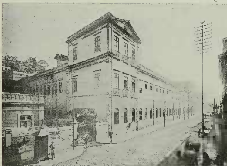
Força Policial — Quartel da Rua Evaristo da Veiga
